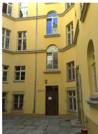
Wejście do części w oficynie
