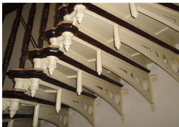
Konstrukcja schodów klatki j.w.
