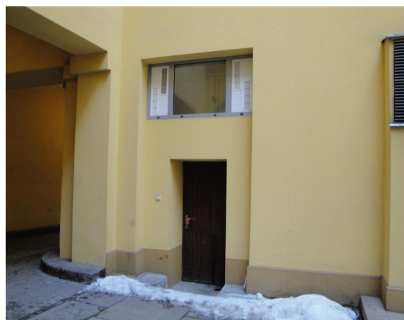
Drzwi usytuowane przeciwległe do drzwi klatki schodowej od placu Solnego
