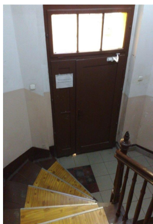
drzwi wejściowe do części w oficynie
