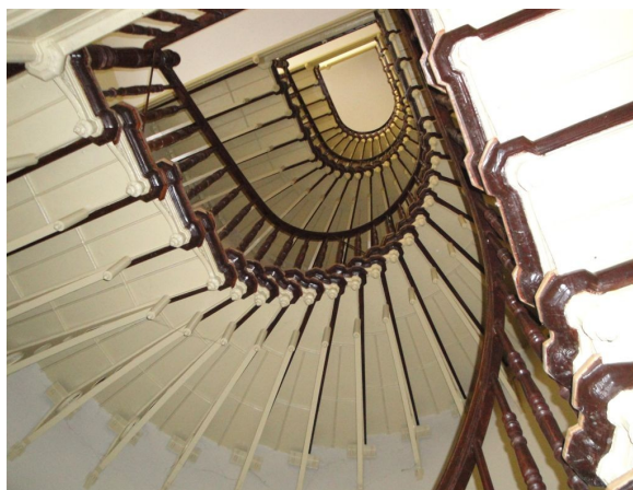
Widok schodów wachlarzowych klatki od strony placu Solnego
